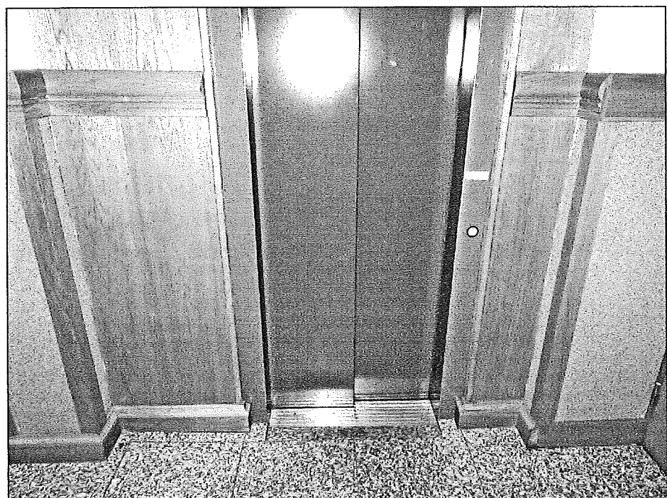
Esošais dekoratīvais portāls šaftas durvim grīdas līmenī
